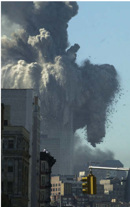
Material von WTC 1, darunter tonnenschwere Stahlträger, wurde explosiv in alle Richtungen und oft bis über 100 m weit weggeschleudert.
