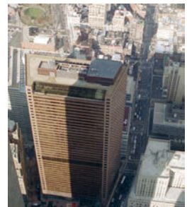
Ein Blick auf das 47-stöckige WTC 7 von der Aussichtsplattform des WTC 2.
