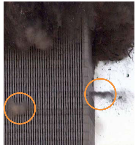
Squibs: In WTC 1 und WTC 2 wurden Trümmer ausgehend von einzelnen punktförmigen Quellen mit hoher Geschwindigkeit seitlich ausgestoßen, oft 20 bis 30 Stockwerke unter der Zerstörungszone.
